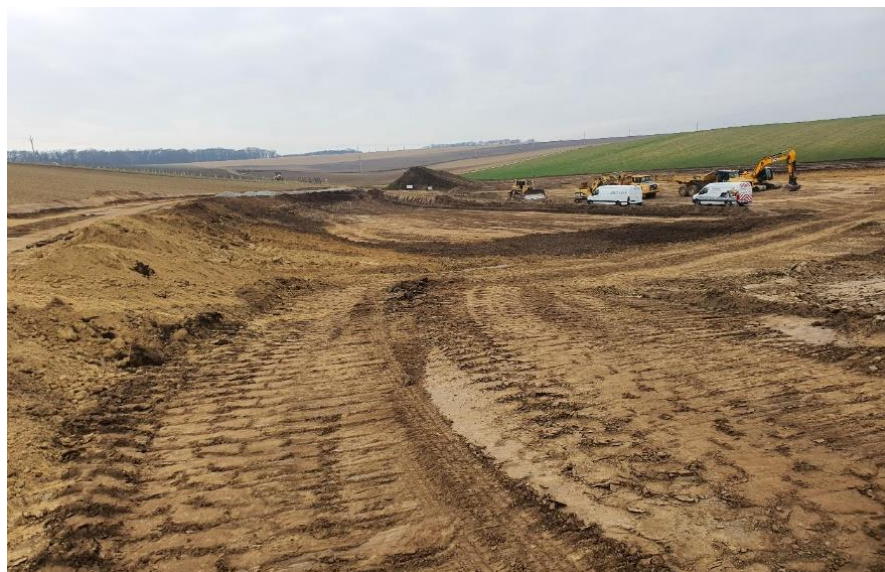
Obrázek č. 8: Budování poldru v lokalitě pod Oborou
